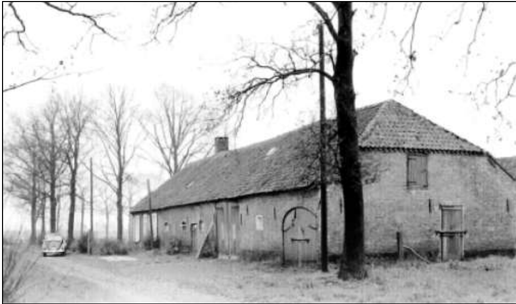
Afbeelding: Hoeve de Vlaas vóór de bouw van het Natuurkundig Laboratorium. 91
