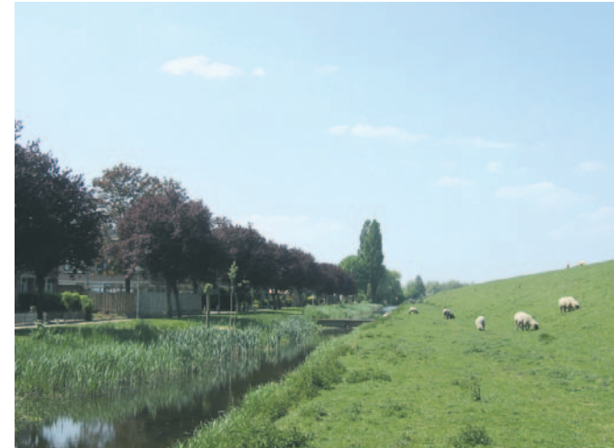
Primaire dijk zonder beplanting bij Heinenoord
