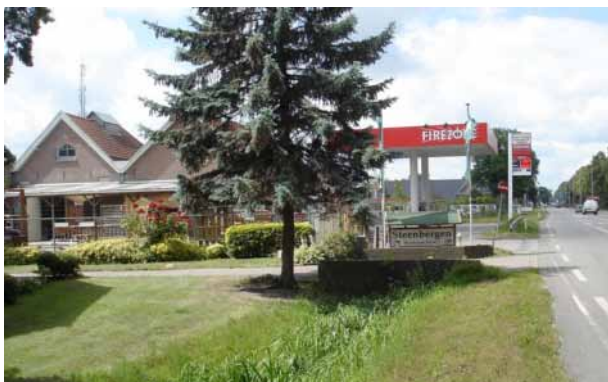
Eenvoudige inrit over bermsloot / te opvallende reclame
