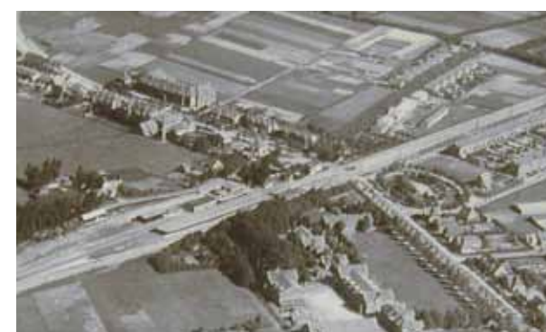
Stationsomgeving Harderwijk ca.1950 (Tweelingstad) boven: aanleg nieuwe Verkeersweg
