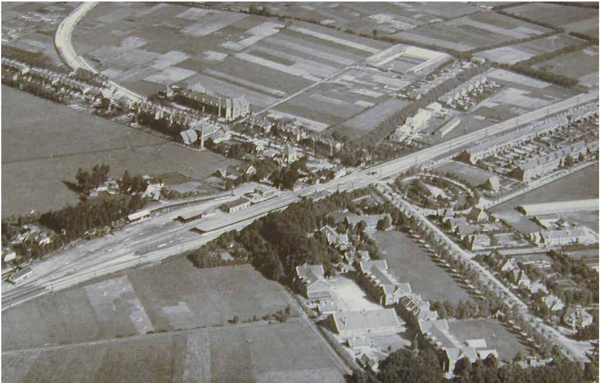
Stationsomgeving Harderwijk ca.1950 (Tweelingstad) boven: aanleg nieuwe Verkeersweg
