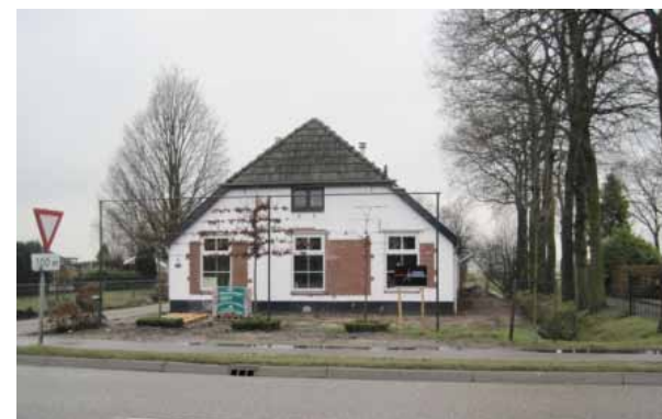
Oldebroek herstel oorspronkelijke gevel
