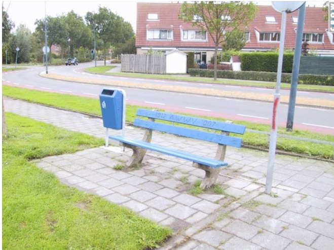
Verharding-open verharding elementenverharding onkruid klinkers
